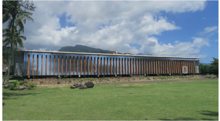
PHOTOS 2 et 3. – Vues extérieures de la nouvelle salle d'exposition permanente du Fare Iamanaha – Musée de Tahiti et des Îles, depuis son jardin (clichés Garance Nyssen, 2023)
